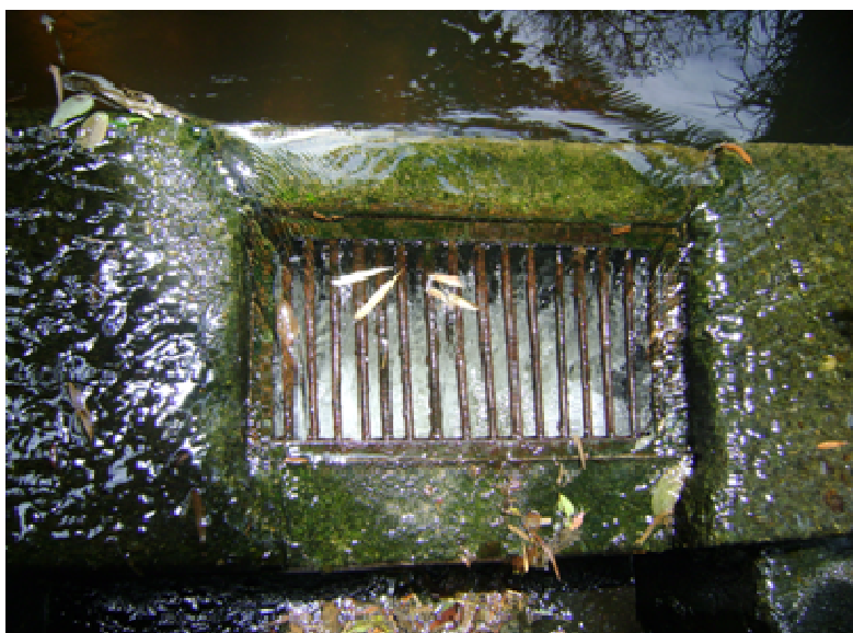
Foto 4. Rejilla de captación bocatoma San Francisco.
