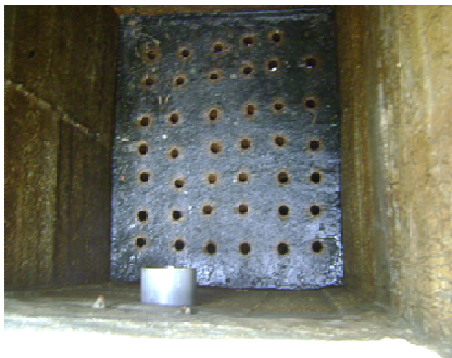
Foto 8. Pantalla deflectora a la salida del desarenador.
